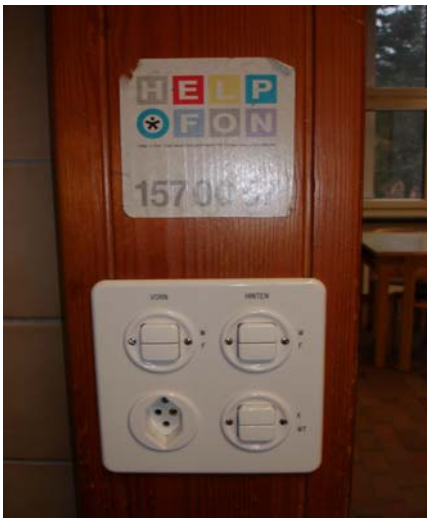
Schulzimmer, Beleuchtung ca. 1998 saniert, zuviele Schaltkreise (6 Stk.)
