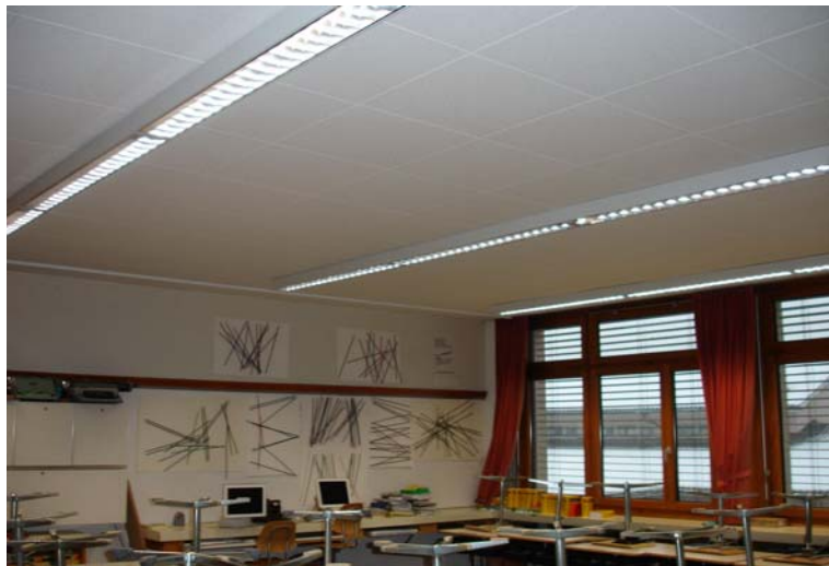
Schulzimmer, Beleuchtung ca. 1998 saniert, zuviele Schaltkreise (6 Stk.)
