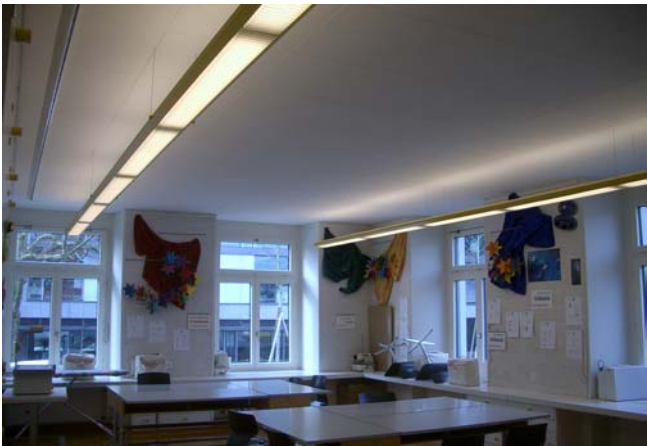
Schulzimmer mit Taster und Schrittschalter-Lösung, Gebäude ca. 1940, Beleuchtung ca. 1997 erneuert.
