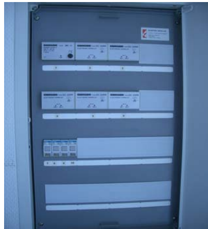
Schulzimmer mit Taster und Schrittschalter-Lösung, Gebäude ca. 1940, Beleuchtung ca. 1997 erneuert.
