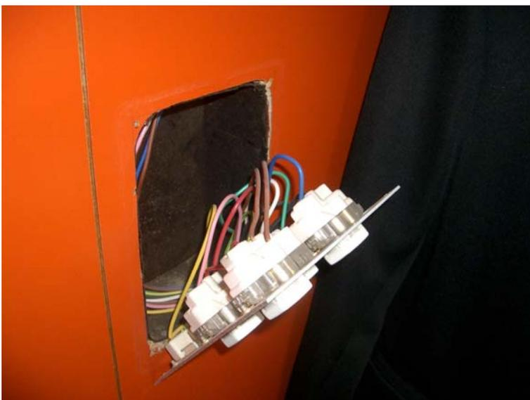
**Bild 1** Schaltstelle in einem Klassenzimmer, Sekundarschulhaus Sternmatt II in Baar der Schaltfaktor muss im Hohlraum hinter der Schaltstelle untergebracht werden (evtl. aufbohren)
