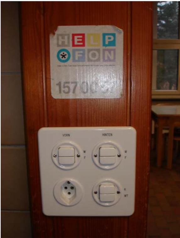
**Bild 2** Schaltstelle in einem Klassenzimmer in Thalwil, zu viele Schaltgruppen sind eher verwirrend, der Akteur könnte an der frei werdender Stelle eines Schalters installiert werden
