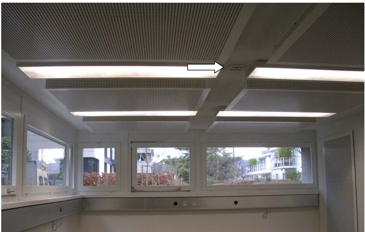
Fig. 5 Pilotanlage Attenhoferstrasse 8 Mit SENSOLUX (Prototyp, Pfeil) ausrüsteter Raum. Einfache Montage des Präsenzmelders durch Anschrauben oder ankleben einer Grundplatte an der Decke. Der PIR wird dann über einen Bajonettverschluss an der an der Grundplatte befestigt.
