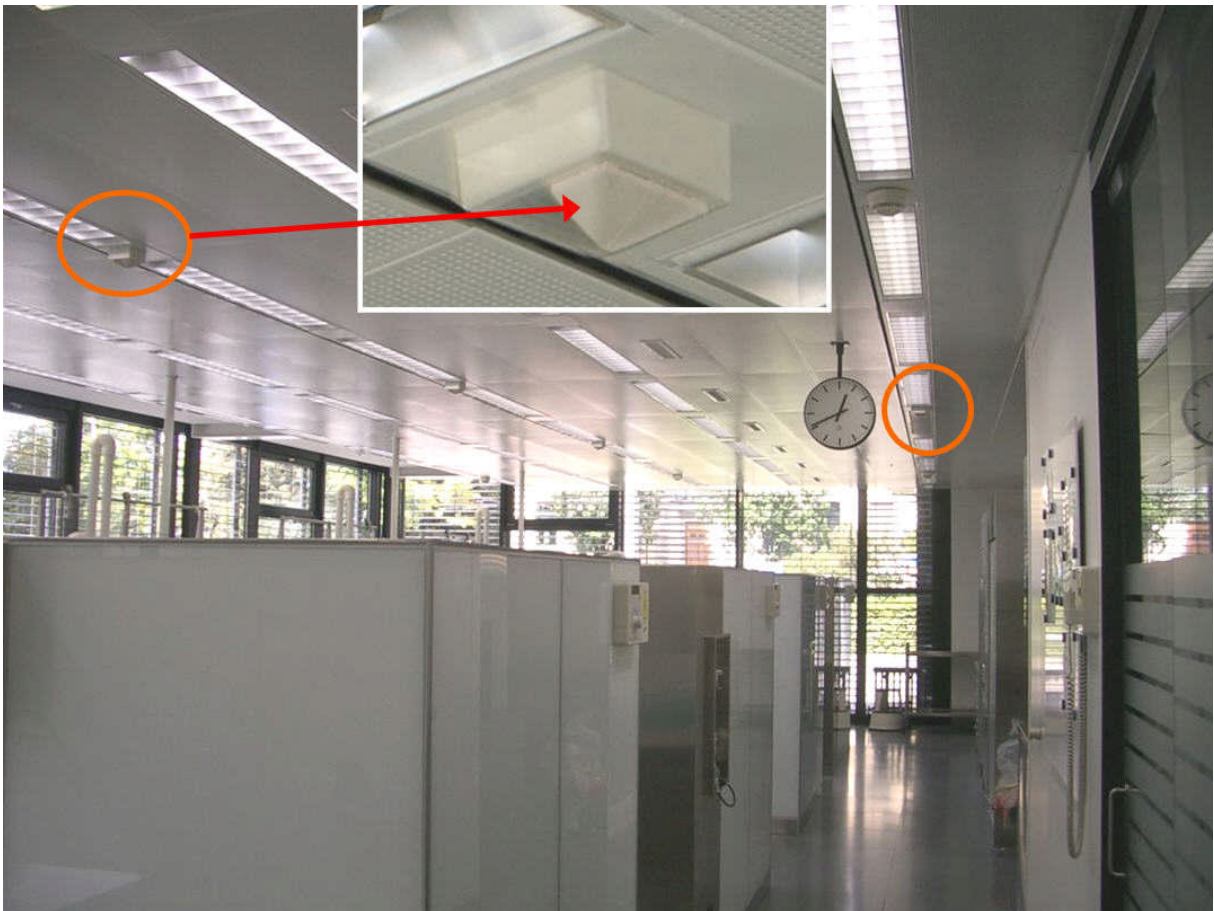
Figur 6: PIR in den Arbeitsnischen (links im Bild) wurden mit Klebeband so abgedeckt, dass sie auf Personen, die sich im Korridor aufhalten nicht mehr reagieren. Im Korridor wird das Licht über separate PIR (rechts im Bild) geschaltet.
