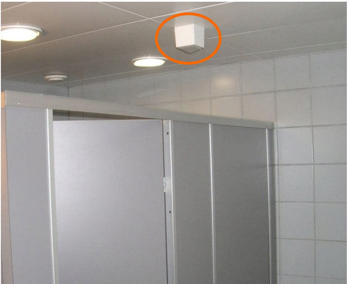
Figur 4: Optimale Lösung: ein Präsenzmelder (PIR) erfasst 2 Kabinen und Vorraum mit Lavabo und Pissoir
