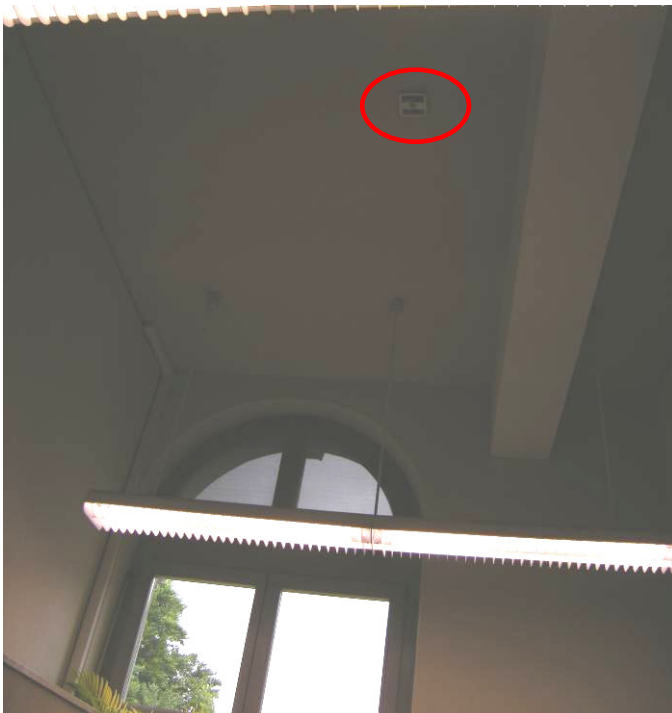
Figur 12: Im kleinen aber hohen Büroraum wurde der Sensolux an der Decke mit einem relativ geringen, aber genügend hohen Tageslichteintrag installiert
