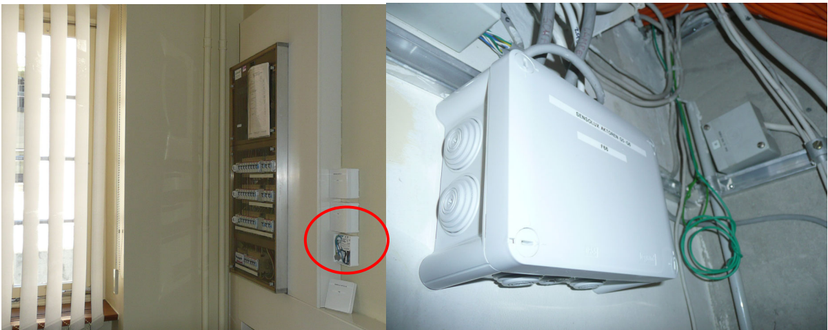
Figur 20: Funk-Aktoren neben und hinter der Stockwerkverteilung montiert
