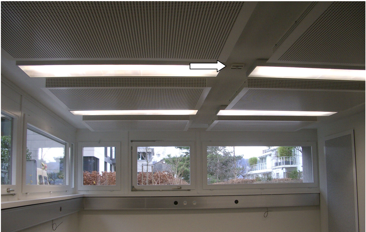
Figur 8: Pilotanlage Attenhoferstrasse 8 Mit SENSOLUX (Prototyp, Pfeil) ausgerüsteter Raum. Einfache Montage des Präsenzmelders durch Anschrauben oder ankleben einer Grundplatte an der Decke. Der PIR wird dann über einen Bajonettverschluss an der an der Grundplatte befestigt.
