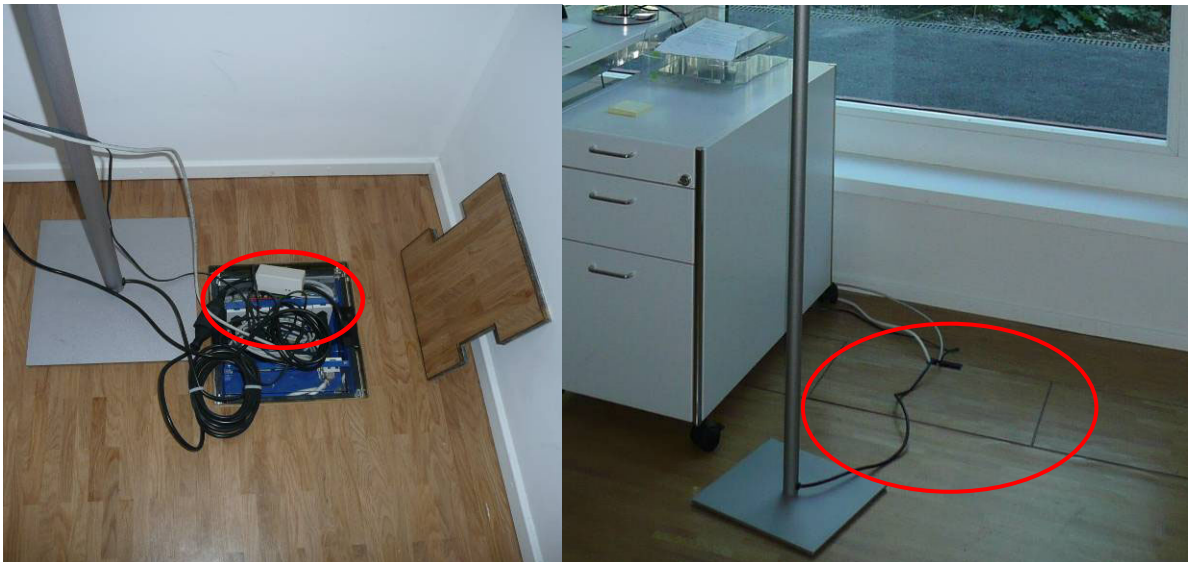
Figur 17: Kabel-Funk-Aktor findet in der Bodendose platz. Auch bei geschlossenem Deckel ist der Funkempfang gewährleistet.
