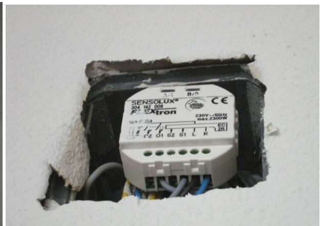
Figur 14: Links SENSOLUX Funk-PIR and Decke eines Einzelbüros montiert. Rechts: Platzierung des Funk-Aktors oberhalb des Schalters in der unterputz Schlaufdose
