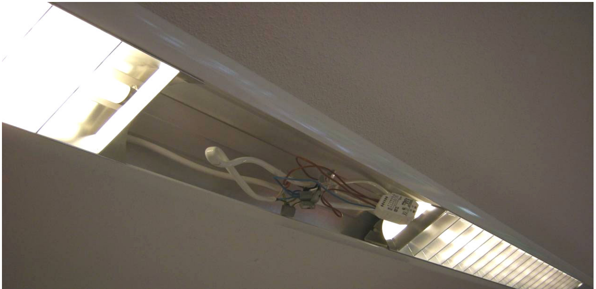
Figur 11: Der Aktor ist unter einem Abdeckblech des Leuchtbandsystems installiert
