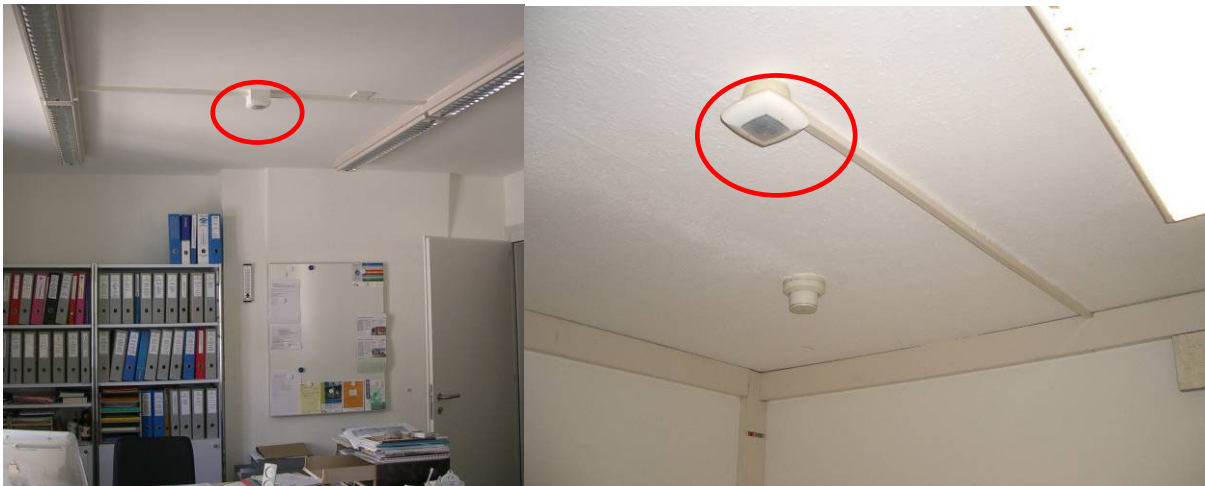
Figur 1: Nachrüstungen mit herkömmlichen Präsenzmeldern (PIR) führen neben dem zum Teil erhöhten Installationsaufwand oftmals auch zu optisch unbefriedigenden Lösungen (PIR rot eingekreist).
