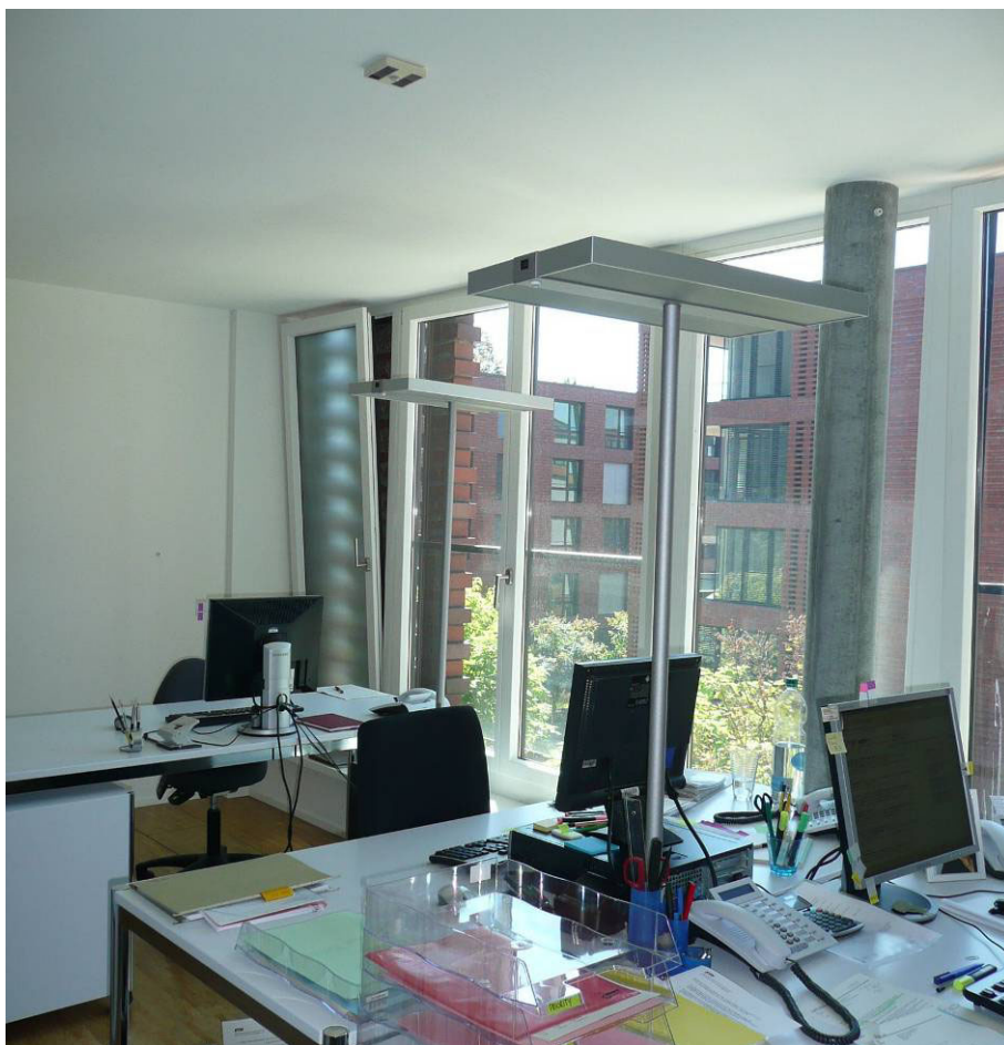
Figur 16: Büro mit Stehleuchte, ungünstig platzierter Sensolux (Beschattung durch Stehleuchte)
