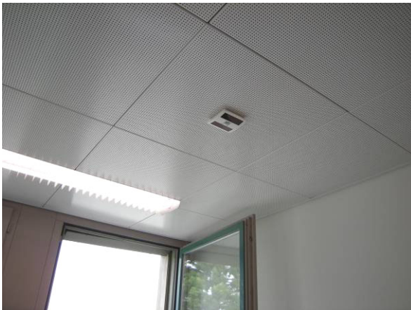
Figur 14: Links SENSOLUX Funk-PIR and Decke eines Einzelbüros montiert. Rechts: Platzierung des Funk-Aktors oberhalb des Schalters in der unterputz Schlaufdose
