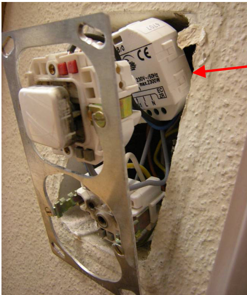
Figur 13: Der Funk-Aktor wurde bei der bestehenden Installation hinter dem Schalter in der Wand bei der Türe im den Lampenschaltkreis installiert
