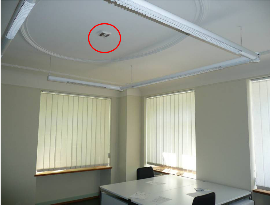
Figur 19: Bestehende Beleuchtung mit Sensolux ergänzt, Sensolux gut gesetzt
