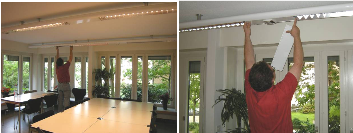
Figur 10: Einfacher Standortwechsel des Sensolux bei der Montage an einem Abdeckblech eines Leuchtbandsystems
