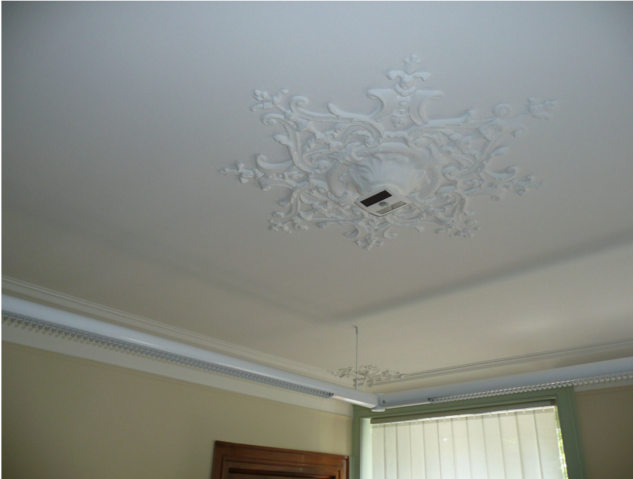
Figur 21: SENSOLUX in Rosette gesetzt (vormals war der Brandmelder an dieser Stelle installiert)
